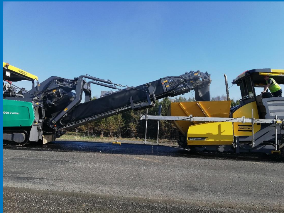
Асфальтоукладка по ультразвуковой лыже
