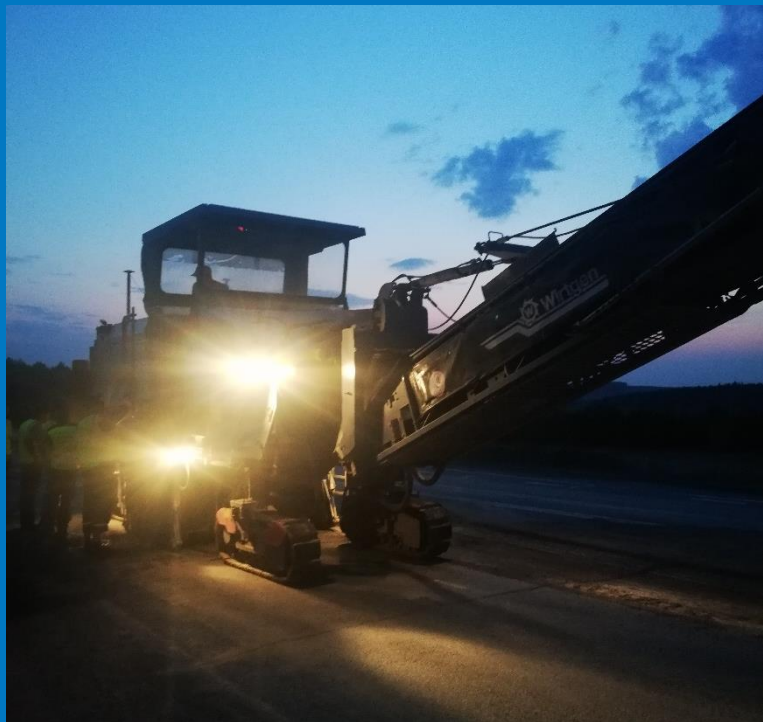
Автоматическое фрезерование в ночное время
