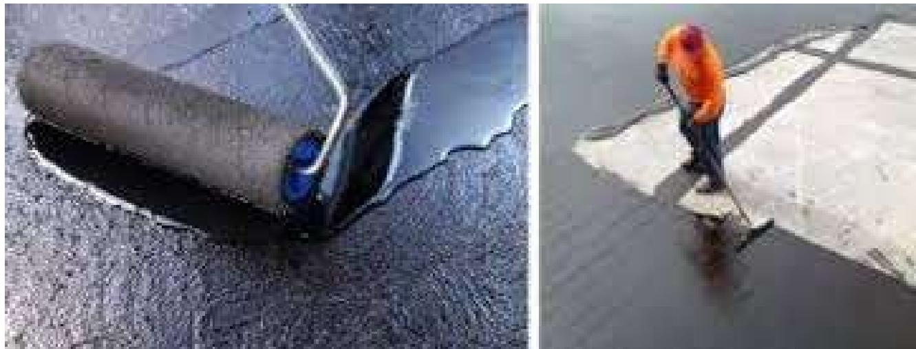
*LEVL Coat 573 - материал на карбоакрилатной основе, обладающий высокими эксплуатационными характеристиками. Покрытие наносят ручным способом. После отверждения покрытие представляет собой прочную эластичную пленку, которая выполняет функцию гидроизоляции основания.*
