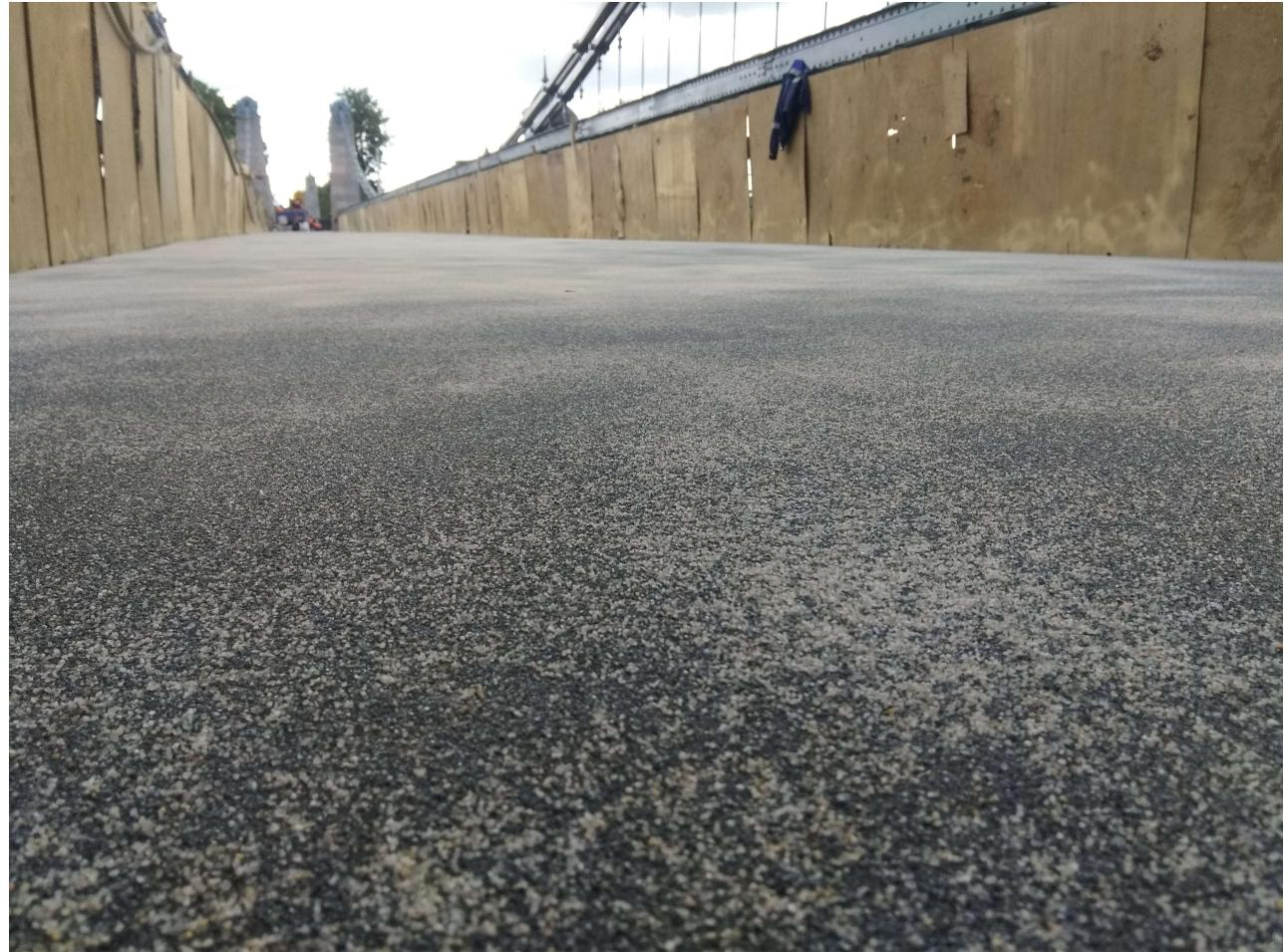
*Желательно не применять для присыпки более крупные фракции наполнителя, чтобы избежать дальнейших проблем при запечатывающем слое и дальнейшей эксплуатации.*
